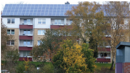
2009 ging die Photovoltaikanlage auf dem Dach der Bürgermeister-Heldmann-Straße 8 und 10 in Betrieb. Foto: Sieland
