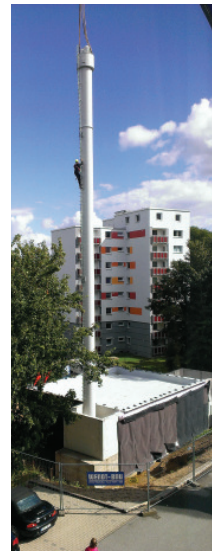
Mit dem Bau von Blockheizkraftwerken (hier am Hochhaus in der Riesbyer Straße 5) leistet das GWU seit Jahren einen Beitrag zur Energiewende.
