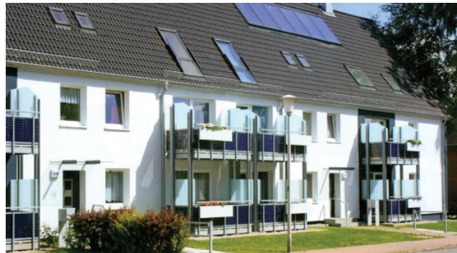
Die Doroteenstraße 57-63 nach der energetischen Sanierung 2009
