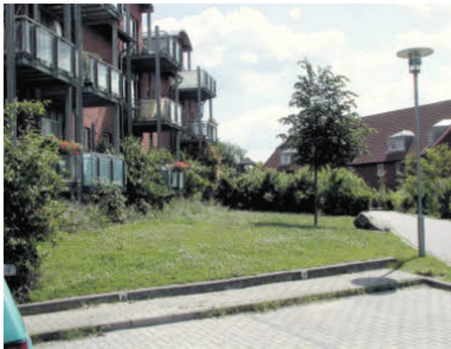
Blick auf die Willy-Brandt-Straße 3 (errichtet in den 90er Jahren). Das Foto stammt aus dem Jahr 2003.
